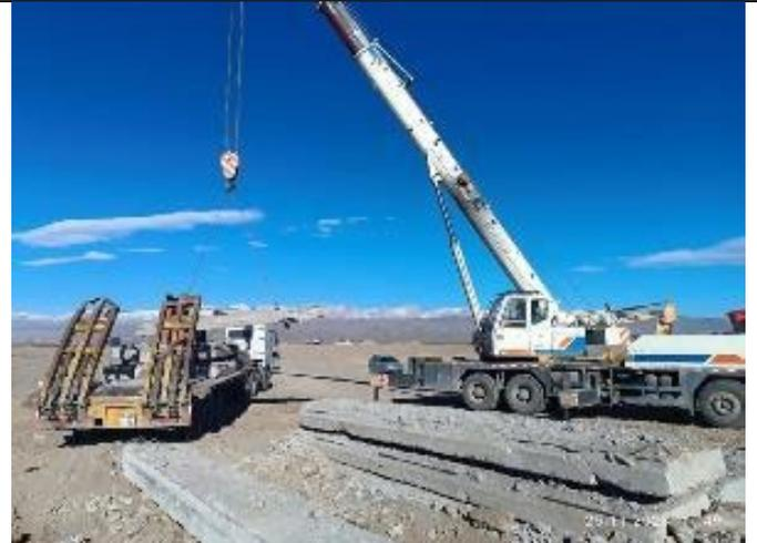
Фото 90. Демонтаж временного моста объездной дороги на км 62+500 через р. Жоон-Арык
