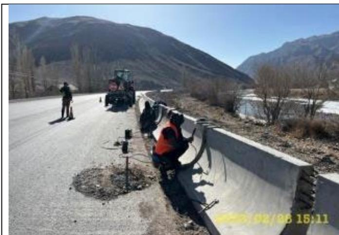
Фото 107. Лот 1. Монтаж установленных парапетов с км 14+000-15+000. Февраль
