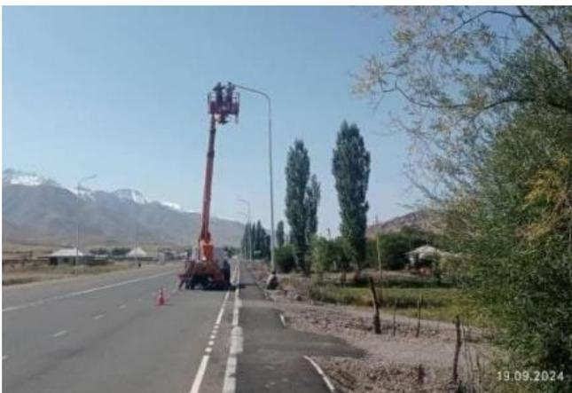
Фото 19. Установка светильников освещения км.86+100-87+700 BS. Сентябрь 2024
