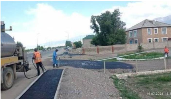
Фото 17. Нанесение prime coat на съездах км 65+648. Июль 2024
