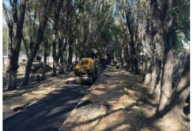
Фото 6. Устройство а/б покрытия тротуара на км 2+050-2+414 LHS. Сентябрь 2024.
