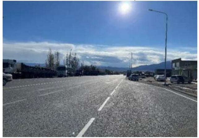
Фото 8. Лот 1, км 0-0+500 завершены работы по освещению, тротуару и обочине (км 0+300). Октябрь 2024
