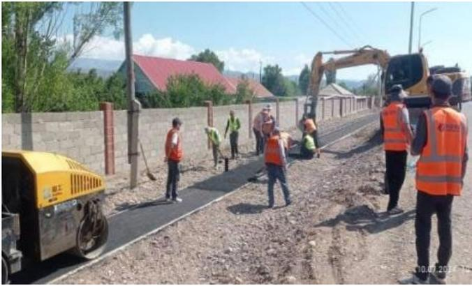
Фото 15. Устройство А/Б покрытия тротуара на км 70+100-70+740 LHS. Июль 2024.
