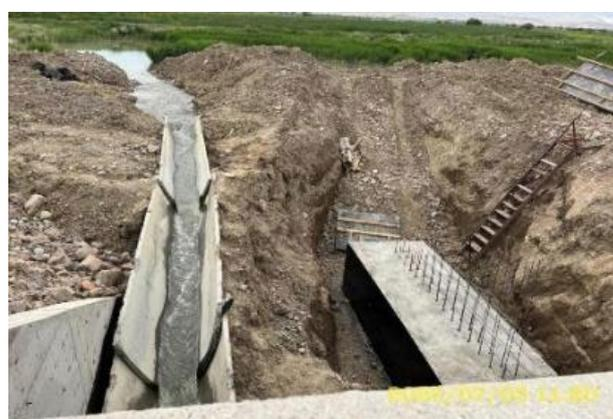
Фото 95. Лот 2. Мост р.Мукандын-Суусу, км. 68+040 Обеспечен отвод воды, предотвращающий попадание грунта в реку, при строительных работах.
