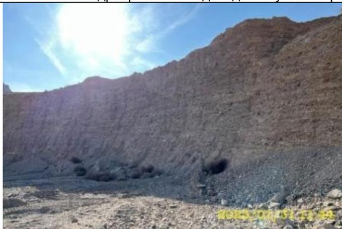
Фото 37. Карьер км 16+600. Отсутствует устойчивость бортов карьера: угол наклона борта карьера составляет 90°, д.б. равным 40-45
