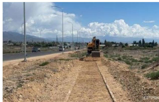
Фото 4. Лот 1. Устройство основания А/Б покрытия на тротуарах км 0+750-1+340 LHS. Июль 2024.
