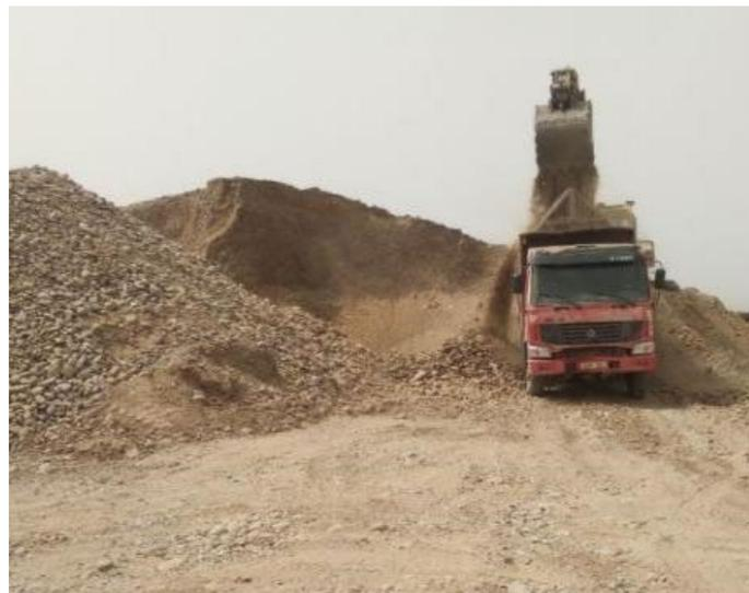
Фото 29. Техническая планировка карьера км 34+240 и приведение откосов борта карьера в безопасное состояние.
