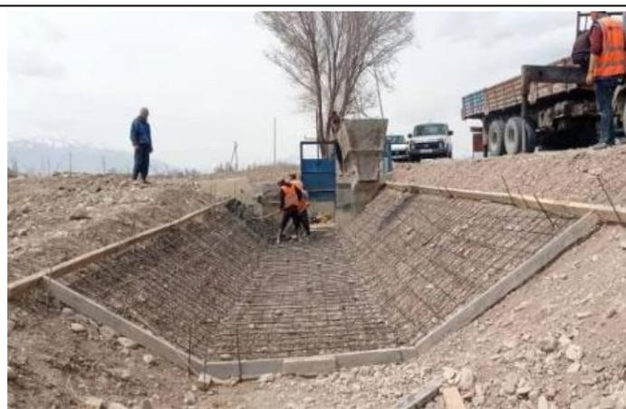
Фото 106. Лот 2. Заливка бетона для укрепления откоса км 64+860.
