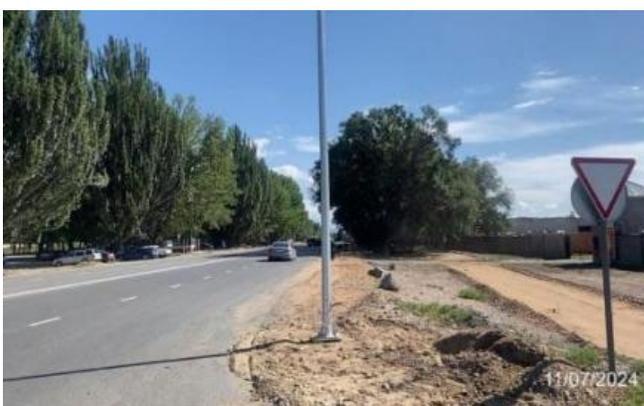
Фото 3. Лот 1. Установка опор освещения на км 0+000-3+000 LHS. Июль 2024.
