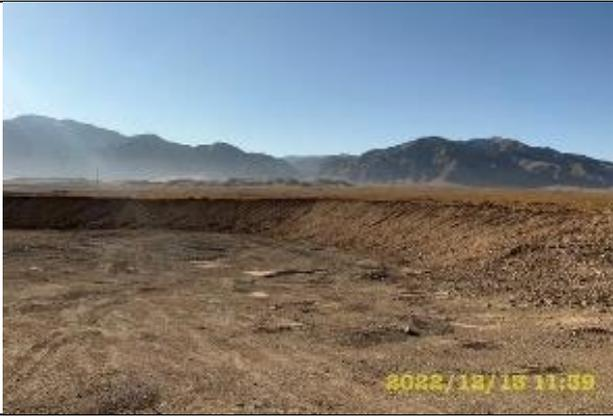
Фото 23. Планировка (техническая рекультивация) карьера, расположенный на км.26+800 LHS.
