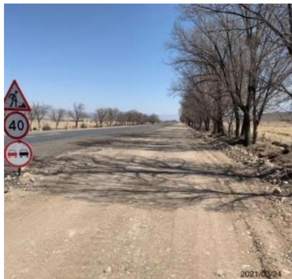
Фото 19 и 20. Обочины дороги с удаленным почвенным слоем
