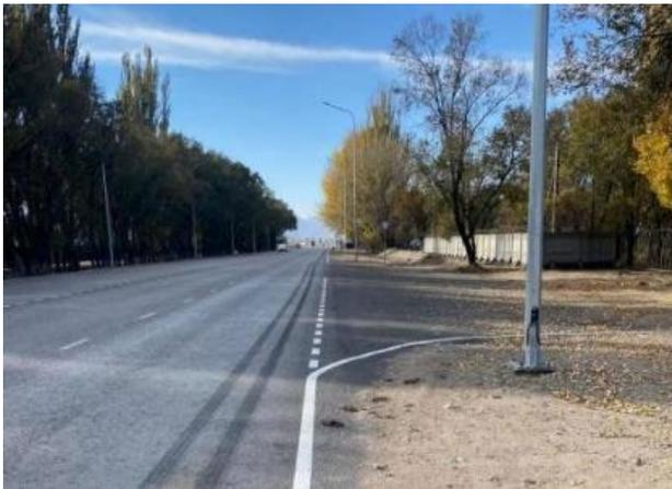
Фото 9. Лот 1, Проложение белой маркировочной линии краевой на км 0+060-3+000. Октябрь 2024.
