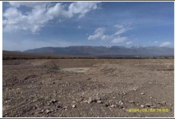
Фото 24. Лот 1. Карьер км. 9+000, техническая планировка, откосы борта карьера приведены в безопасное состояние.
