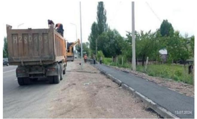
Фото 16. Устройство А/Б покрытия тротуара на км 70+000-70+450 LHS. Июль 2024.
