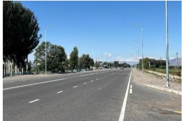
Фото 18. Завершение работ по устройству обочин, бордюров и освещения. Август 2024
