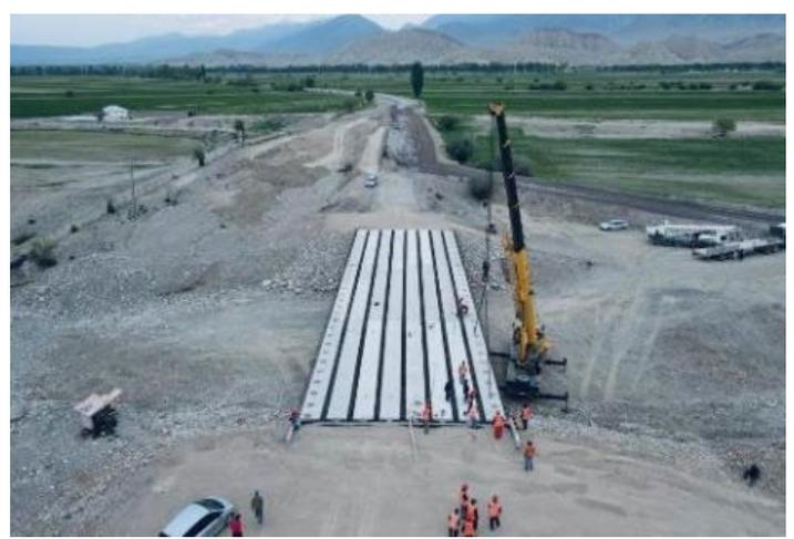
Фото 92. Лот 2. Вывоз демонтированных плит моста на км. 62+400
