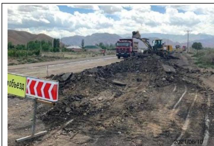
Фото 39. Лот 1. Вскривка и вывоз старого асфальтобетона на км.7+560 в старый карьер на км 7+100
