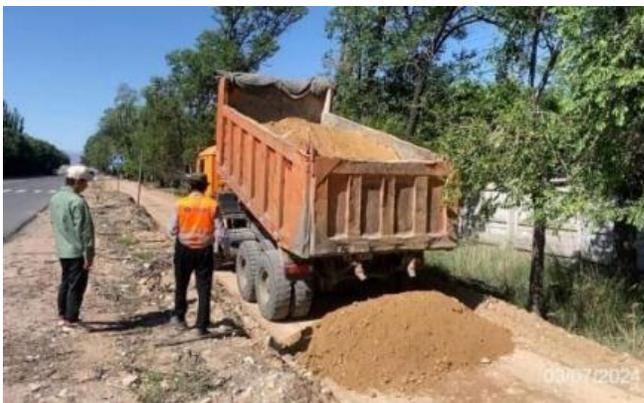
Фото 1. Лот 1. Насыпь для тротуара на км 1+950-2+100 RHS. Июль 2024.
