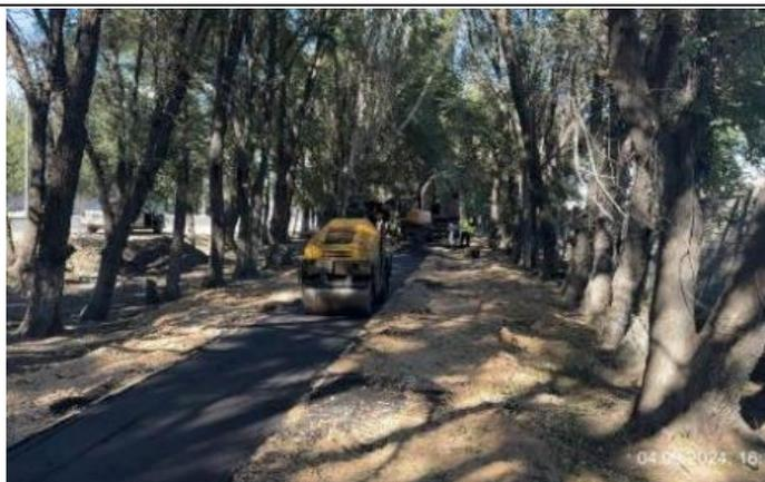
Фото 84. Устройство а/б покрытия тротуара на км 2+050-2+414 LHS. Сентябрь 2024.
