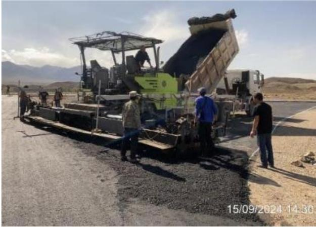
Фото 7. Лот 1. Устройство А/Б покрытия съезда на км 22+641 LHS. Сентябрь 2024
