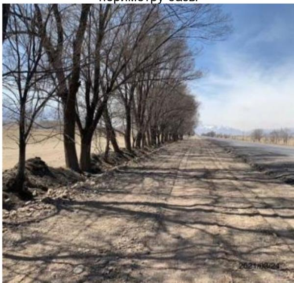
Фото 18. Лот 1. Уширение дороги на участке км. 17+500–18+500: после расчистки и корчевания
