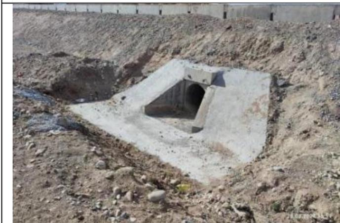
Фото 105. Лот 2. Строительство укрепления на входе трубы, км.88+692
