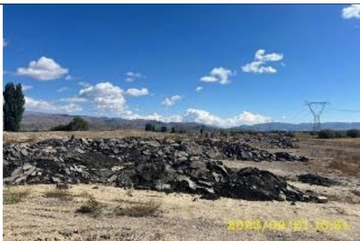
Фото 50. Вскривка асфальтобетонного покрытия на км. 74+550
