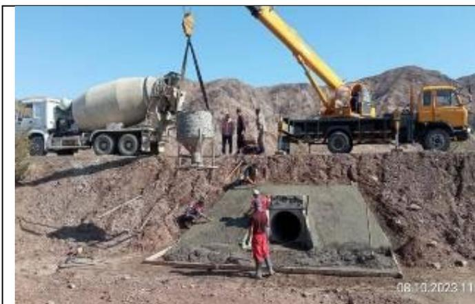
Фото 101. Лот 1. Укрепление входа и выхода бетоном водопропускной трубы на 18+326BS.
