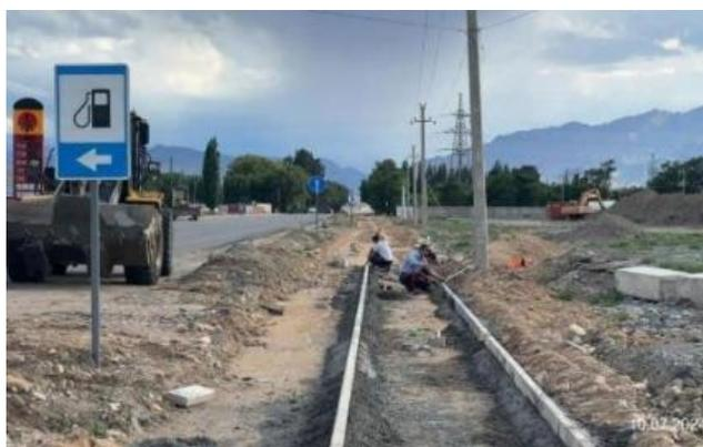
Фото 2. Установка бордюров для тротуара на км 1+360-1+800 RHS. Июль 2024.
