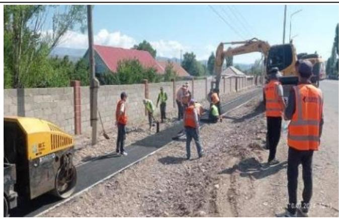
Фото 85. Лот 2. Устройство А/Б покрытия тротуара на км 70+100-70+740 LHS.
