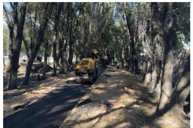
Фото 20. Устройство а/б покрытия тротуара на км 2+050-2+414 LHS. Сентябрь 2024.
